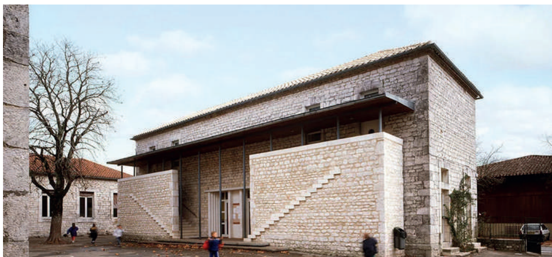
Escaliers de l'école primaire - © J. L. Rames
